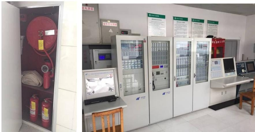
图 8-2 灭火器、消防栓及火灾报警总控制系统
