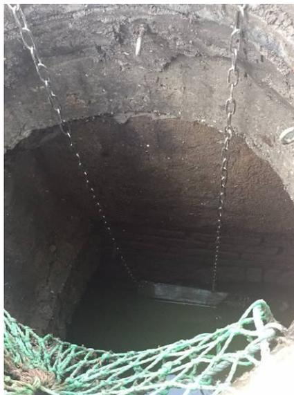
图 8-5 雨水总排口手动截止闸板
