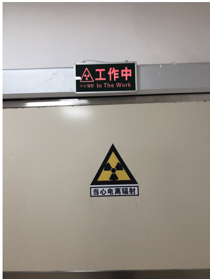
图 3-5 介入室（一）机房门指示灯及电离警示标识
